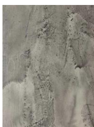
Beton grob grau
